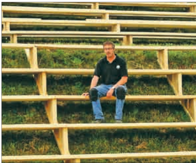
Die Hangtribüne steht bereits. Noch wartet aber viel Arbeit auf Bauchef Markus Käiser. Am kommenden Samstag findet der grosse Aufbau-Tag statt.
